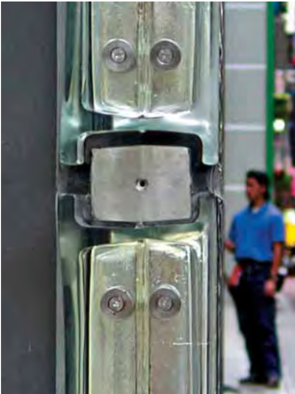
Dettagli di costruzione dei pannelli. Giunti tra pannelli Construction details of the panels. Joints between panels SEVES per Renzo Piano
